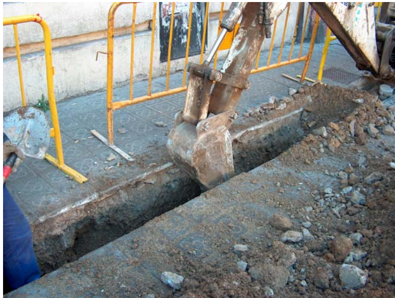
Foto 2: Obertura de la rasa a màquina.
